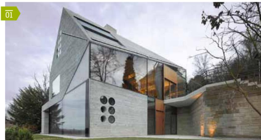
Am Rande von Stuttgart ist ein außergewöhnliches Wohnhaus entstanden: Erstmals entstand in Deutschland ein Gebäude, bei dem die komplette sichtbare Hülle aus konstruktivem Dämmbeton besteht. Nicht nur die Außenwände, sondern auch das gefaltete Dach wur-
